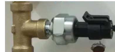
мал. 1 Датчик тиску під'єднано до водогону.
